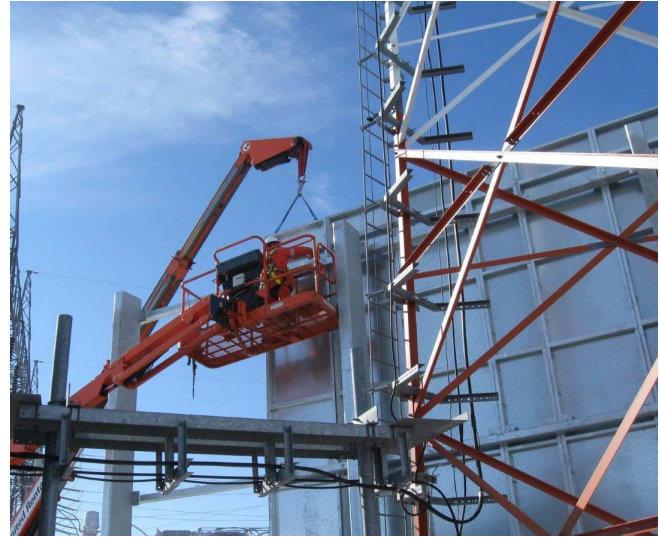
Module DuraBarrier en cours d'installation.
