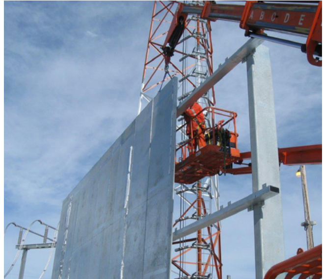
Instalación de Acoustic DuraBarrier al lado de una maquinaria ruidosa.
