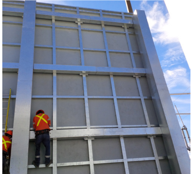
Una instalación de Ballistic DuraBarrier con protección de vigas.
