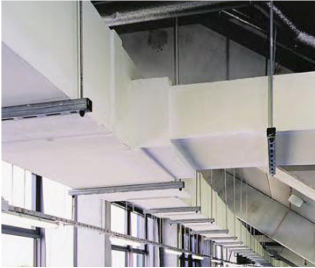
Instalación de DuraDuct 3HR.
