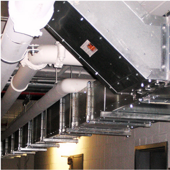
La instalación de DuraDuct GNX en un estacionamiento subterráneo.
