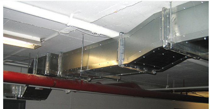
La instalación de DuraDuct GNX en un estacionamiento subterráneo.
