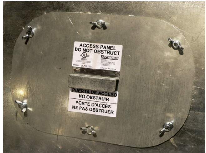
La instalación de una puerta de acceso plana.
