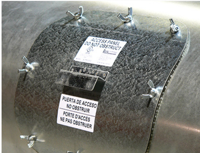
La instalación de una puerta de acceso curva.
