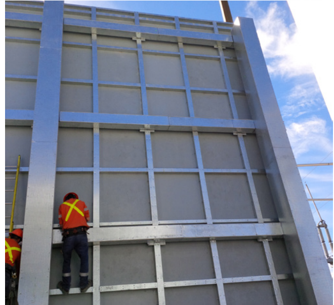
Installation d'un dispositif de protection balistique DuraBarrier avec protection des poutres.
