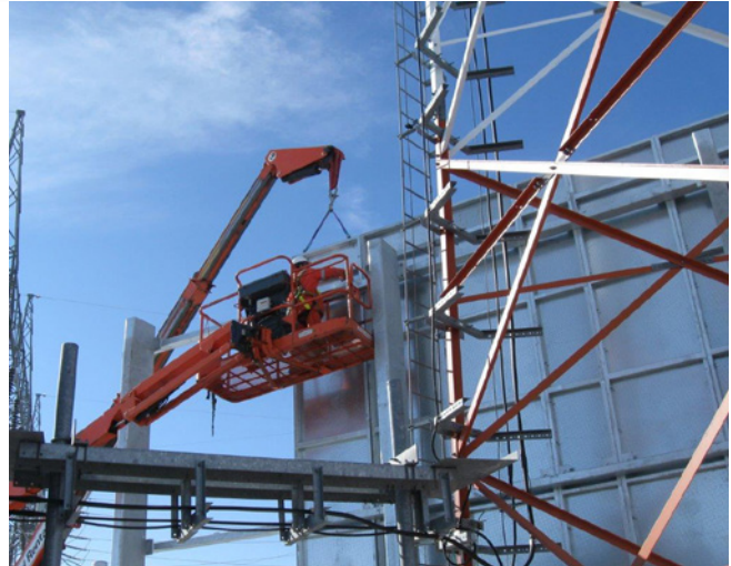
Instalación del módulo DuraBarrier.
