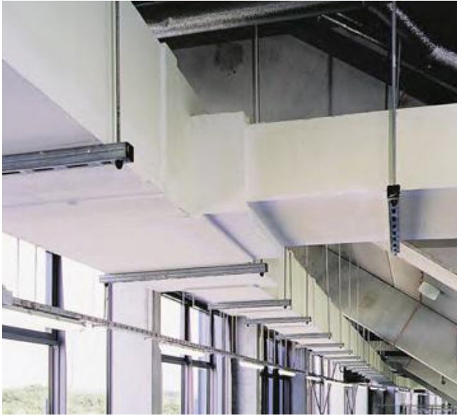
Installation d'un DuraDuct 3HR.
