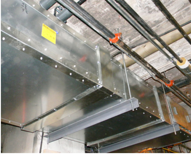
Instalación de DuraDuct KEX.
