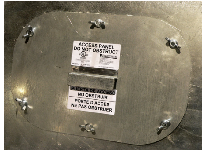
Installation avec trappe d'accès platew.
