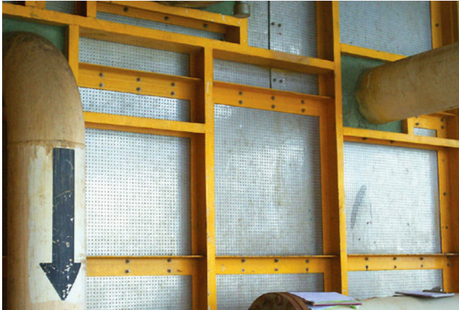
Mur H0 avec joints de pénétration pour tuyaux.
