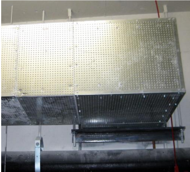
Installation d'un DuraDuct™ 4HR
