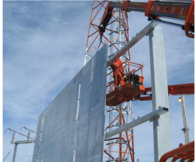
Instalación de Acoustic DuraBarrier al lado de una maquinaria ruidosa.
