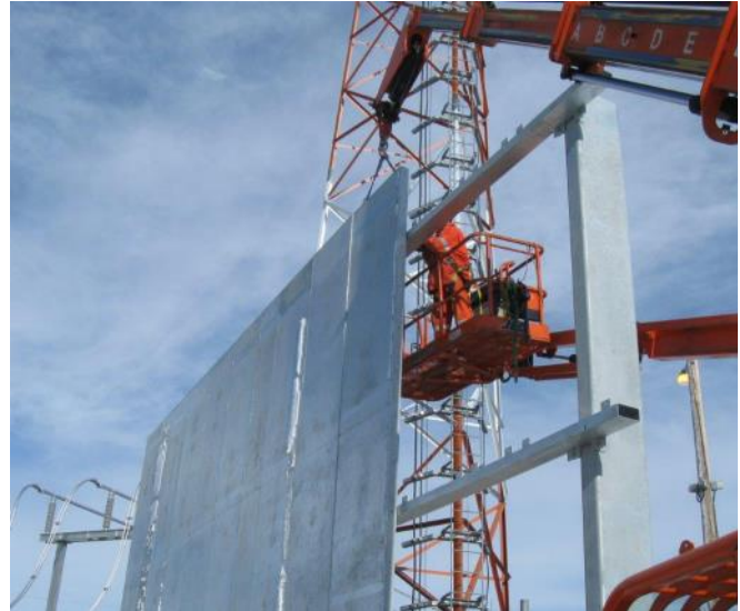
Écran antibruit DuraBarrier® en cours d'installation à côté d'une pièce de machinerie bruyante.
