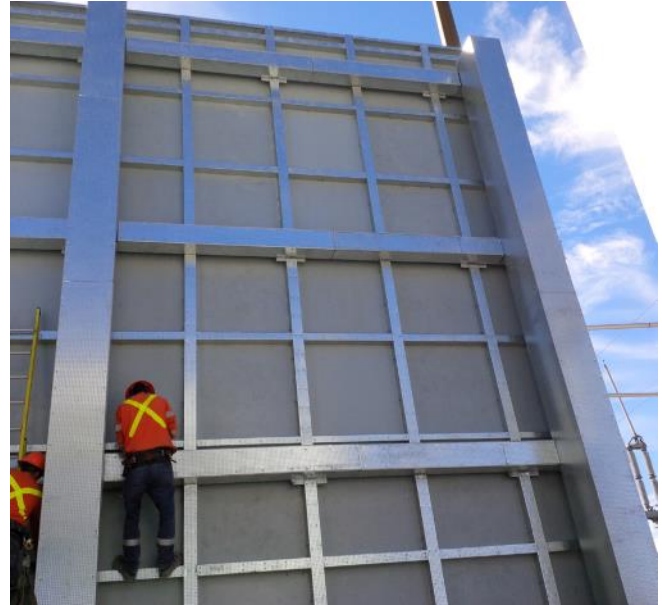
Installation d'un dispositif de protection balistique DuraBarrier®.
