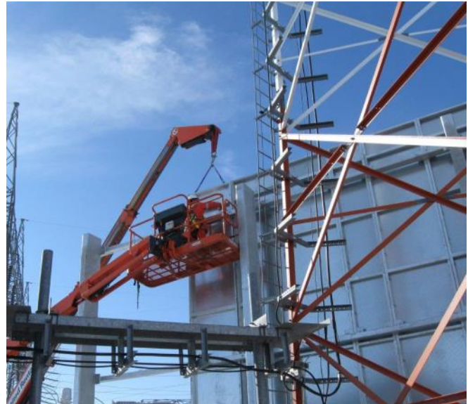
Module DuraBarrier® en cours d'installation.
