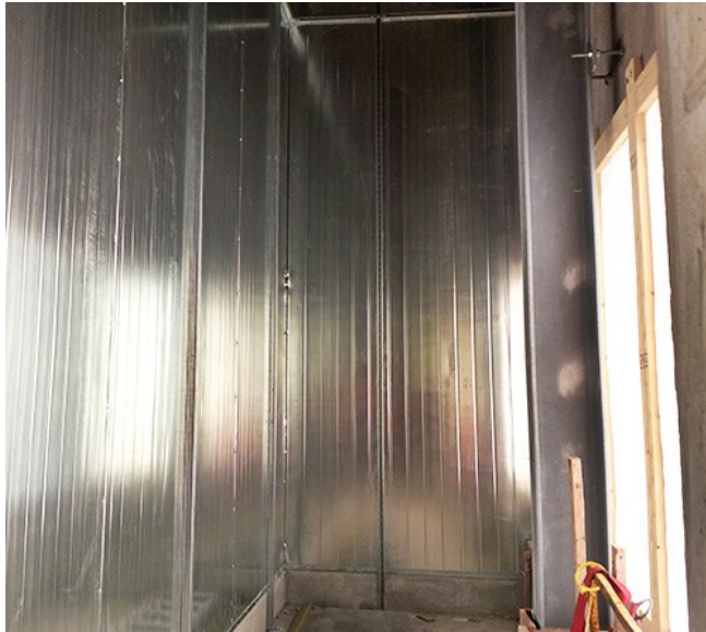
DuraTherm™ intake plenum.
