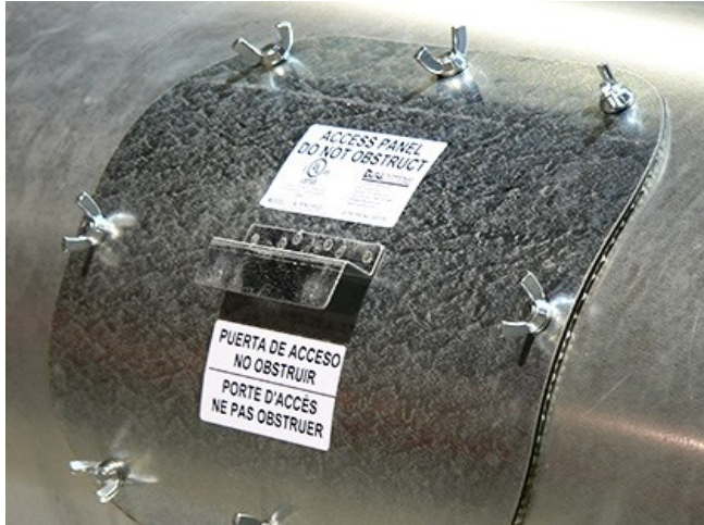
La instalación de una puerta de acceso curva.
