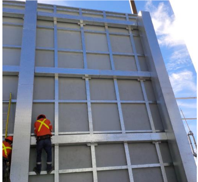
Installation d'un dispositif de protection balistique DuraBarrier®.
