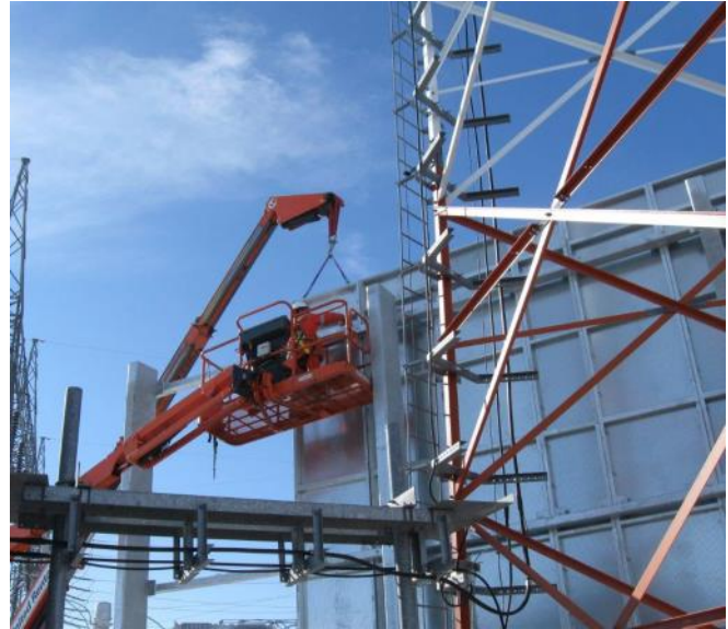
Se está instalando el módulo DuraBarrier®.
