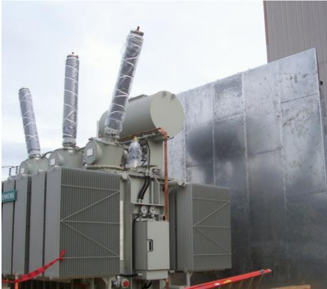
La cara frontal de una instalación DuraBarrier®.
