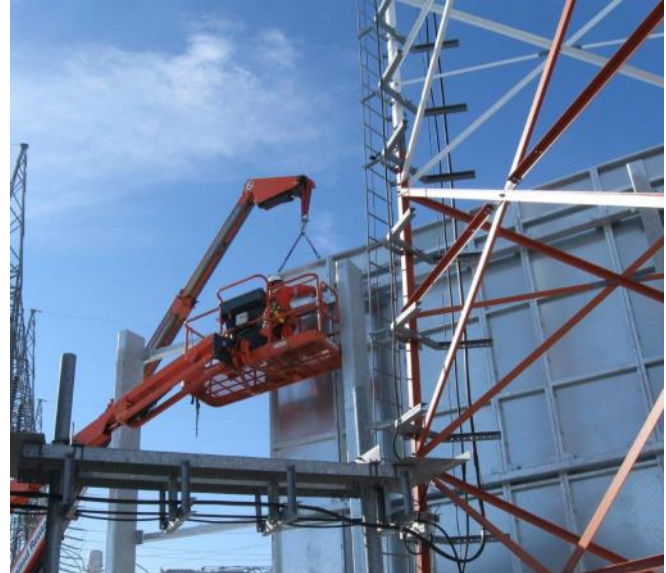
Module DuraBarrier® en cours d'installation.
